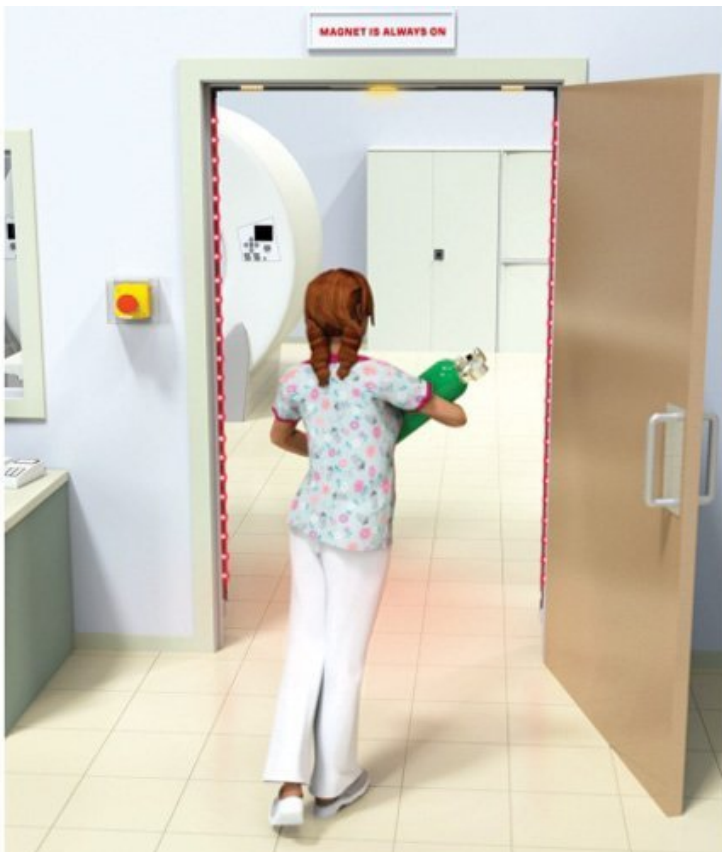
Активация световой сигнализации при приближении к системе сотрудника с кислородным баллоном из ферромагнитного сплава.
