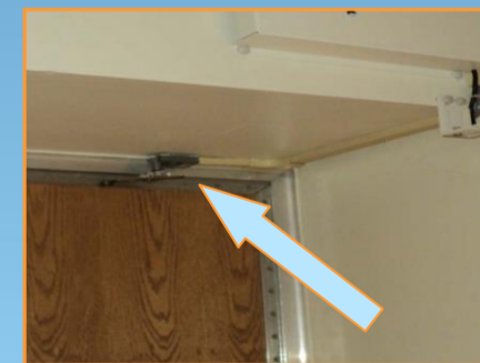
Рисунок 3. Доводчик двери, который активирует детектор только при открытой двери МРТ.
