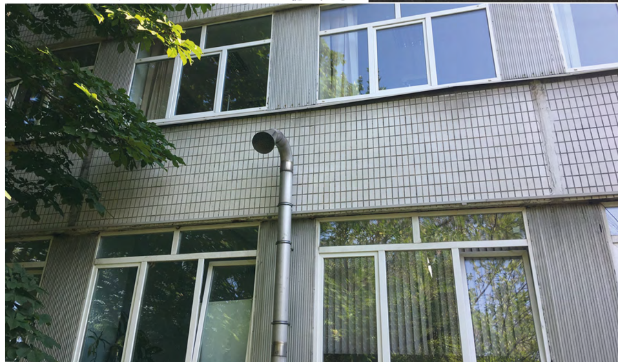
Рисунок 14 – Примеры некорректного вывода квенч-трубы
